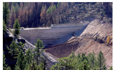
Los Alamos Dam New Mexico (2000)
